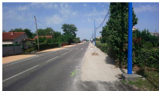
La traverse d'agglomération de St Jean de Falga avant l'engagement du chantier. Photo CD09
