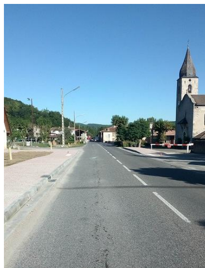
Traverse de l'agglomération de Caumont.
