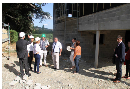
Visite du chantier des futures salles de classe et de musique au collège François-Verdier à Lézat.
