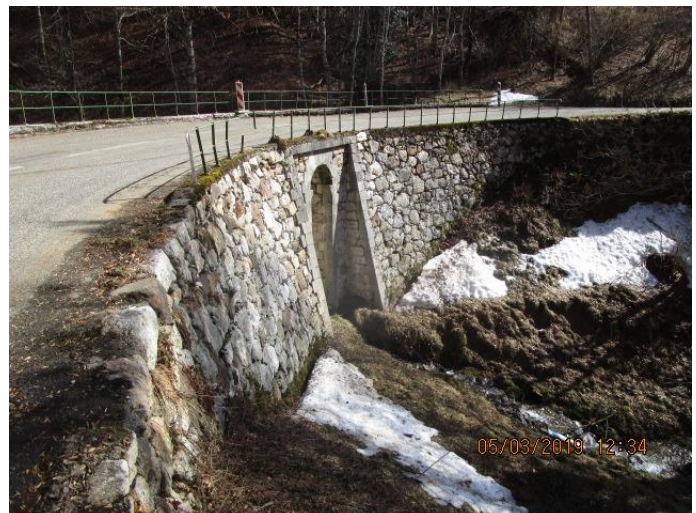
Pont sur le ruisseau de la Barguère, sur la RD 618. Photo CD09
