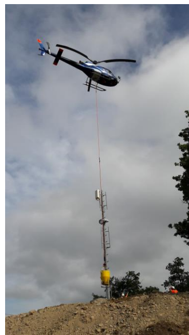
La pose du pylône, au lieu-dit « Camps del Bayle » à Gudas. Photo CD09.
