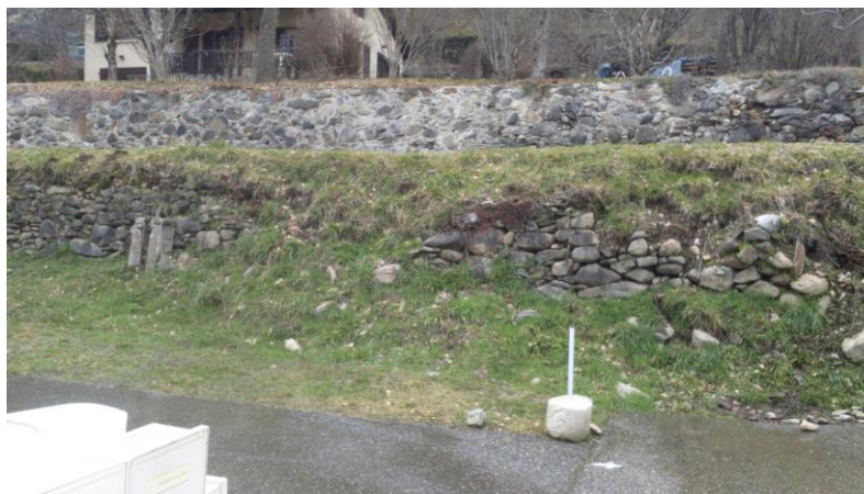
Site des travaux de reconstruction, Photo CD09
