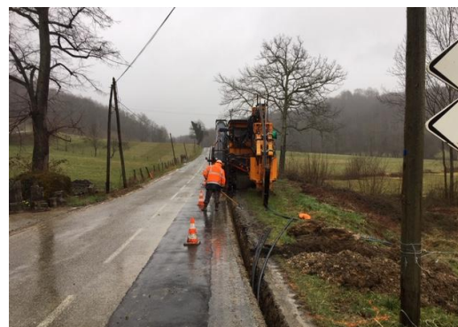
Chantier d'enfouissement de la fibre optique Photo CD09
